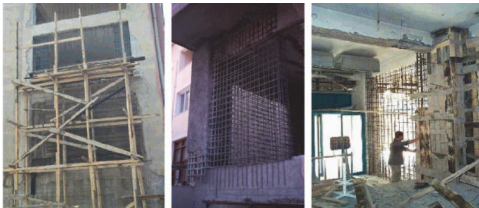
Figura 5.17 Costruzione di parete all'interno della maglia strutturale
