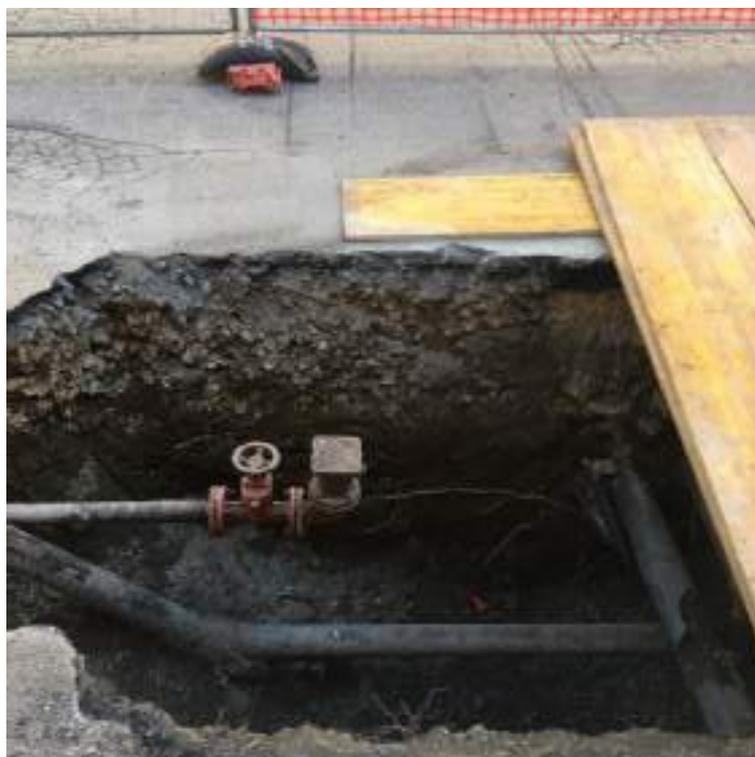
Figura 2 | Fotografia raffigurante le stratigrafie del manto stradale: lo strato d'asfalto appoggia direttamente sugli strati di inerti compattati. Fonte: Federico Brogini, Marzo 2023.
