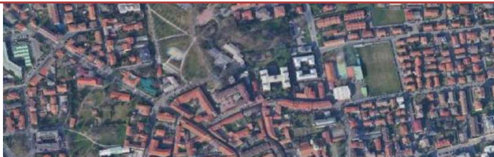
Edificato consolidato a sud del Comune di Roma
