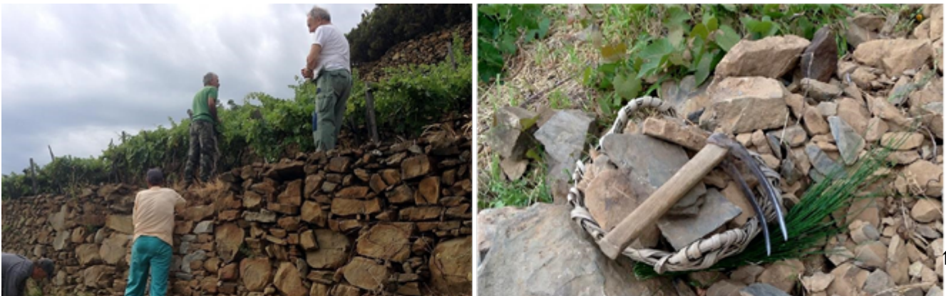
Fig. 3 – Manutenzione muretti a secco nel Parco Nazionale delle Cinque Terre. Fonte: Archivio fotografico PN Cinque Terre
