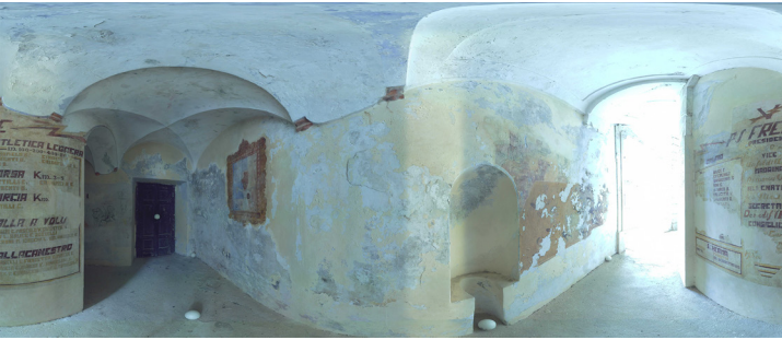
Fig. 17 (on the left). Vista d'insieme di alcuni dei disegni sui muri dei prigionieri fascisti. Zona Ovest dello scalone. Equirettangolare da TLS | Drawings on the walls of fascists prisoners. West side of elliptical staircase (TLS equirectangular).
