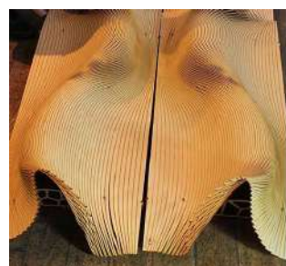
Fig. 12/ Tagli passanti. Distribuzione dei tagli in funzione della superficie di progetto. Mamou-Mani Architects and Buro Happold Engineering, the Wooden Waves , vincitore del Golden Winner 2016 - American Architecture Prize.
