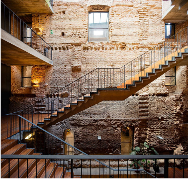
Fig. 2. Madrid, Centro Culturale Ecuélas Pías di Lavapiés, José Ignacio Linazasoro, 2004 (da < http://www.diedrica.com/search/label/Jos%C3%A9%20Ignacio%20Linazasoro?m=0 >).
