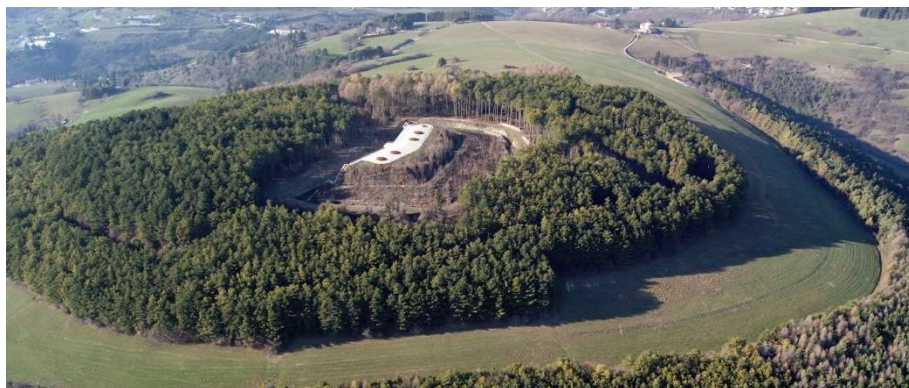
Figura2. Forte Santa Viola.
