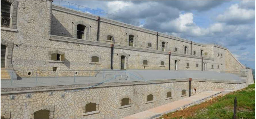
Figura5. Forte Tesoro, fronte di gola.
