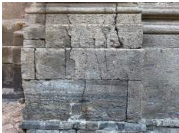
Fig. 4. Napoli, Museo Archeologico Nazionale. Prospetto meridionale, particolare del basamento in piperno al piano terra (Amore 2022).
