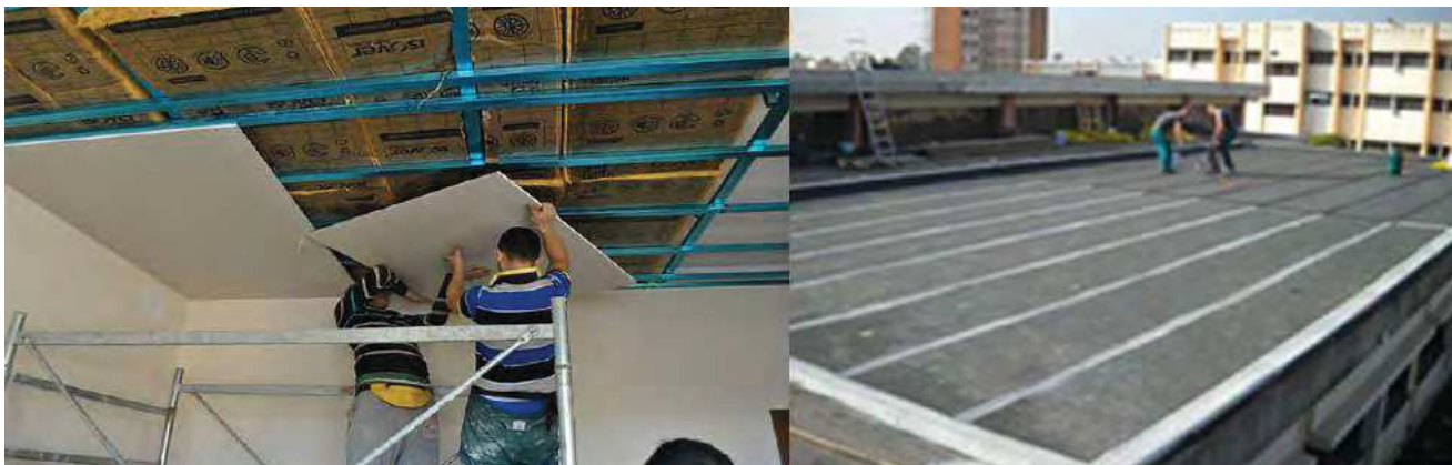
2: Detenuti impegnati nei lavori di ristrutturazione e impermeabilizzazione delle coperture della Casa Circondariale di Torino.
