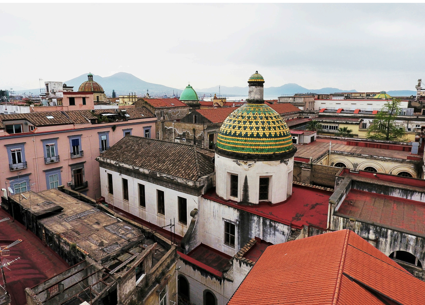
Fig. 1. Napoli, vista delle coperture nel centro storico. Si notano i rivestimenti in coppi e tegole di cotto, rame, piombo ed embrici maiolicati (fotografia da drone di M. Facchini, Dip. di Architettura, Mlab, 2016).
