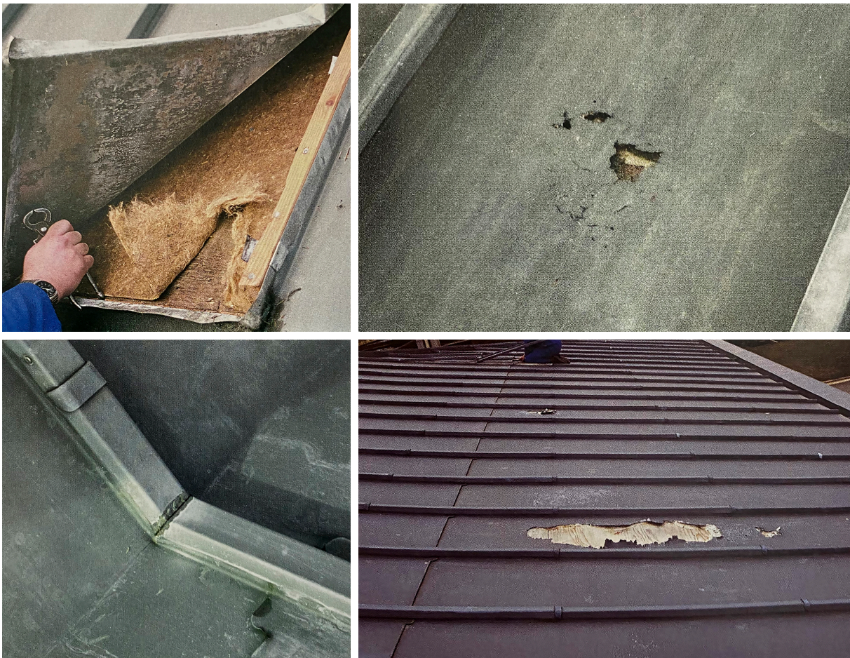
Fig. 12. Gran Bretagna: esempi di fenomeni di degrado delle lamine di zinco (elab. dell'autrice da WOOD, HENRY 2013, pp. 505-506).
