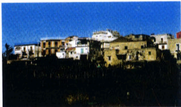
Fig. 12 – Nelle unità di transizione le strutture rurali risultano spesso inglobate in unità edilizie avulse dalle connotazioni locali.
