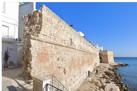
Fig. 1 - Monopoli, il tratto di mura a nord del sito di Porta Vecchia e, in fondo, il bastione di Pappacenero (Wikimedia Commons).
