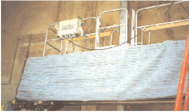
La mantovana parasassi e protezione delle aree del cantiere
