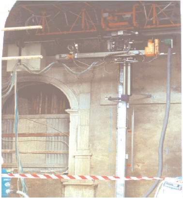
Il cantiere di sperimentazione: Palazzo civico di Atripalda (AV)
