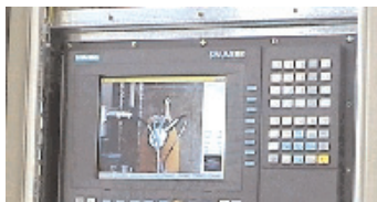
Monitor per il controllo dell'avanzamento delle operazioni
