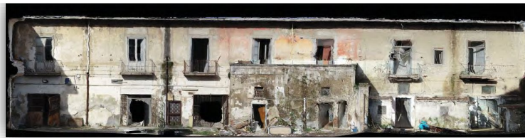
Figura 2 - Ortofoto Prospetto Sud – Corpo a elle
