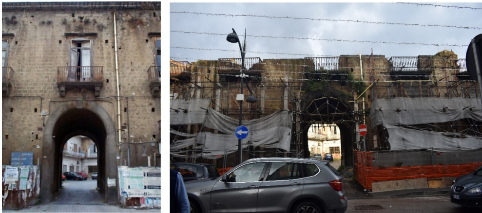
Figura 6 – Immagini pre e post demolizione parziale del fronte su Corso Umberto I
