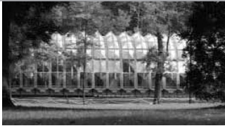
1986_piano r._padiglione mobile IBM
