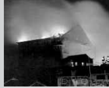
1996_il teatro la fenice brucia in un incendio
