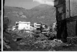
1998_alluvione di sarno
