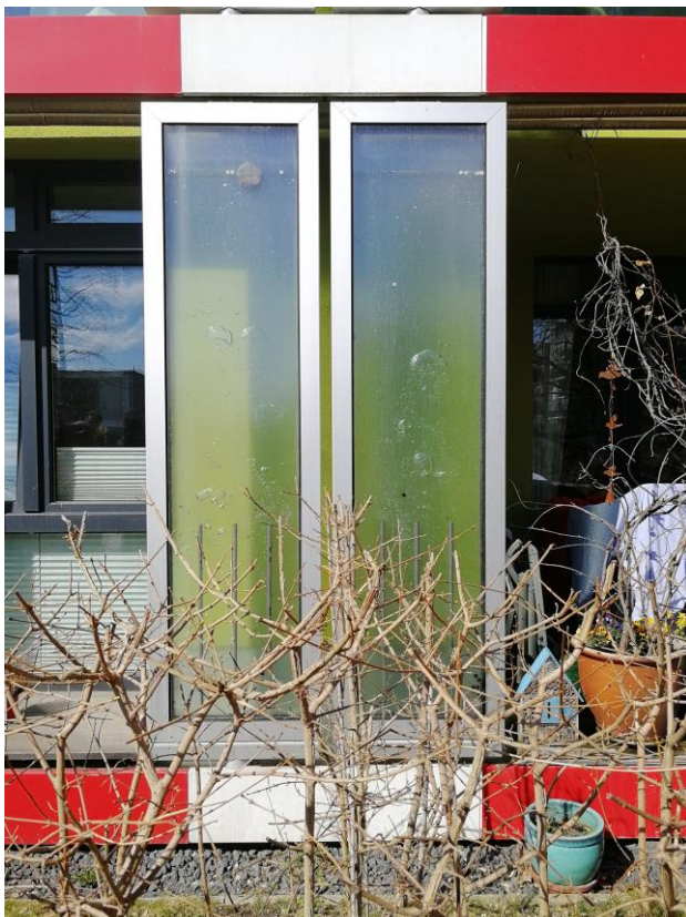
Fig.26 BIQ House, dettaglio del pannello bioreattore sul fronte sud-est dell'edificio. È visibile la miscela acqua-aria in azione (foto: Anita Bianco, aprile 2018)
