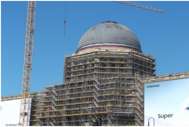
Fig. 40_ Cantiere del Berliner Schloss attualmente in costruzione sull'Isola dei Musei (foto: Dell'Acqua, 2018)
