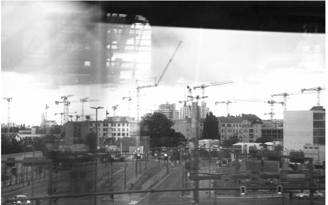
Berlino, edilizia residenziale in costruzione tra i quartieri di Mitte e Moabit. La crescita della città impone modelli di sviluppo compatibili con le necessità di espansione e contemporaneamente di adattamento climatico (foto: Dell'Acqua, 2018)
