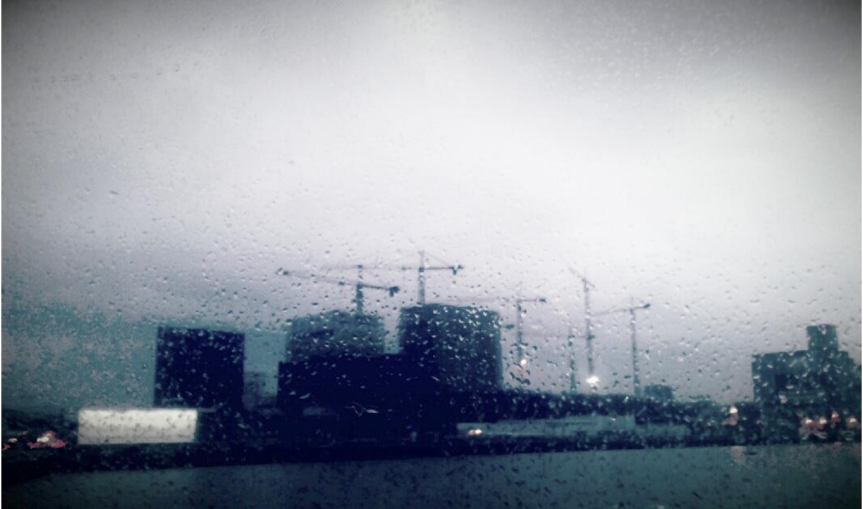
Fig.12_ Rotterdam, Olanda. Edifici in costruzione sulla sponda fluviale. Foto: F. Dell'Acqua, 2018
