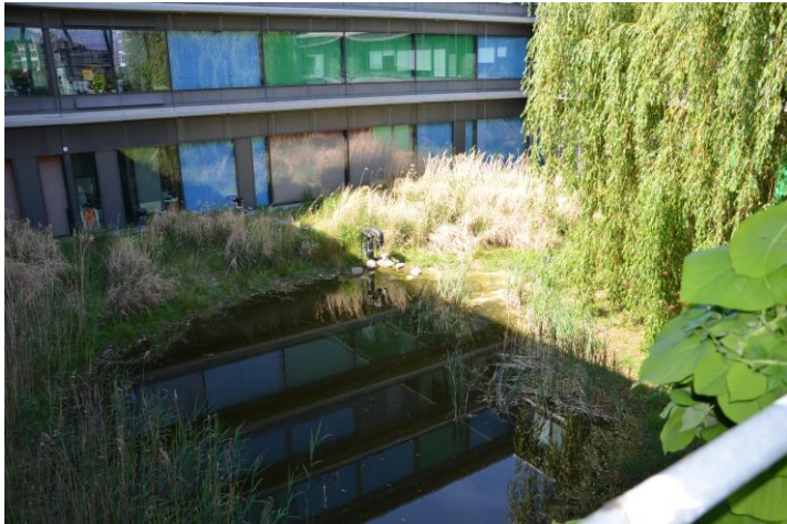
Fig. 36 _ Una delle corti centrali con lo stagno per la raccolta delle acque meteoriche e il raffrescamento, foto: F. Dell'Acqua, 2018
