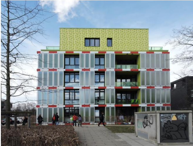
Fig.25_BIQ House, vista fronte sud-est della facciata in pannelli bioreattori (foto: Anita Bianco, aprile 2018)
