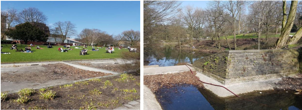
Fig. 48_Amburgo, Planten und Blumen Stadtpark. Sistemi e bacini di ritenzione delle acque meteoriche a protezione dal rischio flooding cui sono soggetti i canali (foto: M. Losasso, 2018)
