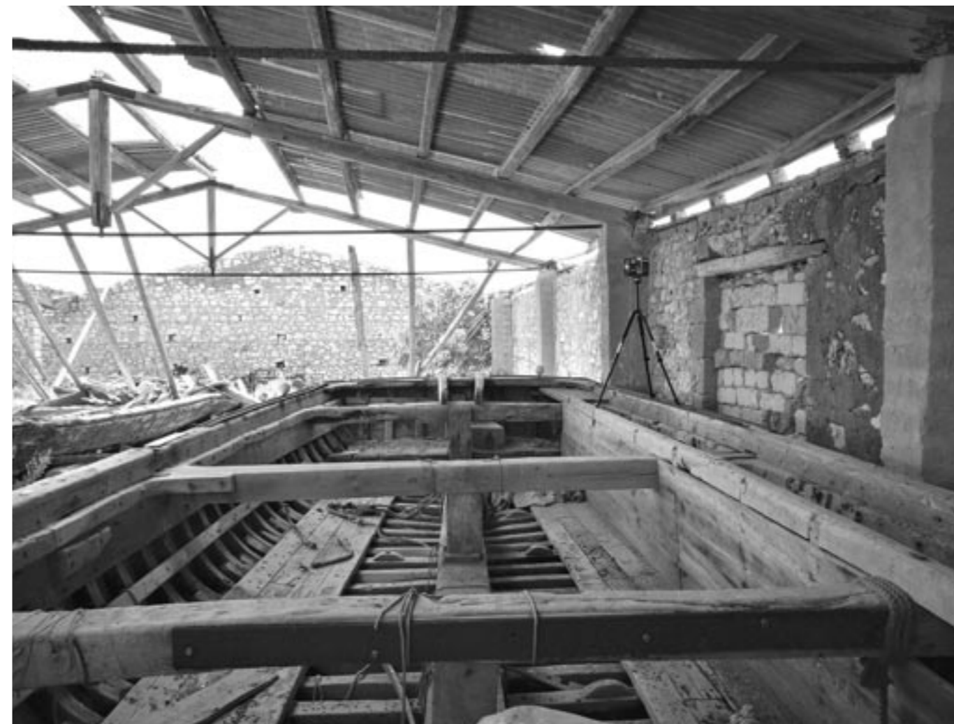
Fasi di rilievo dello sciere all'interno della trizzana su Capo Passero
