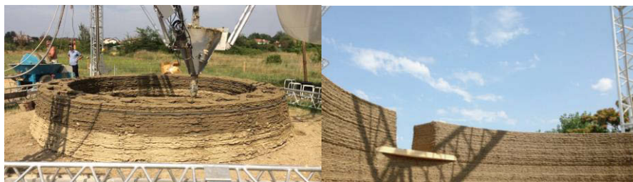
Figura. 7 – Muri in terra e paglia in stampa 3D – Shamballa, Parco tecnologico di WASP.
