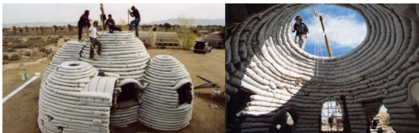
Figura. 2 – Eco-Dome, Gibuti - Costruzione con sacchi di sabbia o terra – Nader Khalili (2011).
