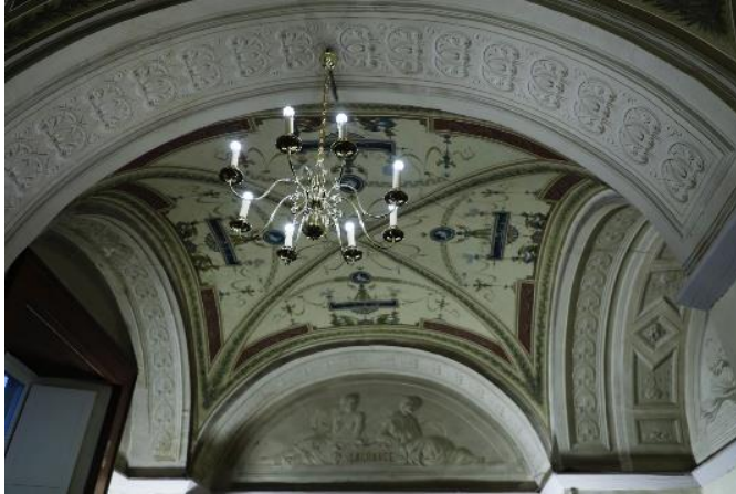
Figura 8. Soffitto della Sala Battaglini
